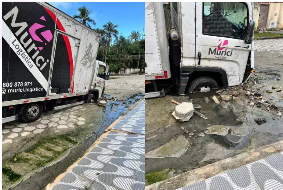
Figura 1 - ATRIBUNA - Veículo passava por rua que recebeu obra da Sabesp em Guarujá (Arquivo pessoal)
