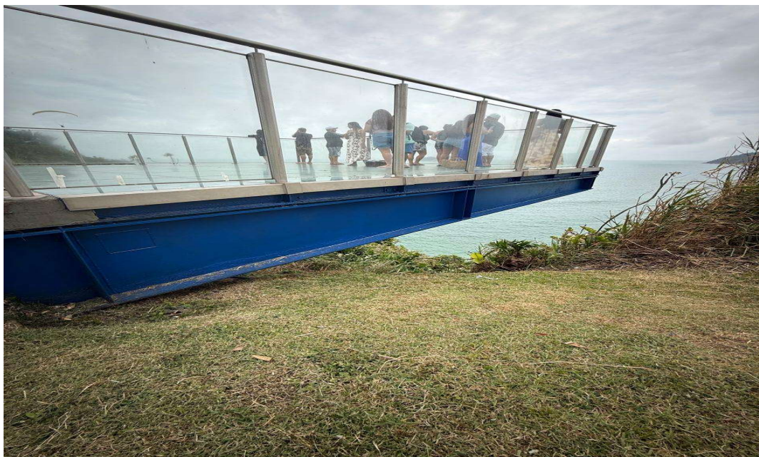
Imagem V – Recuperação estrutural realizada.
