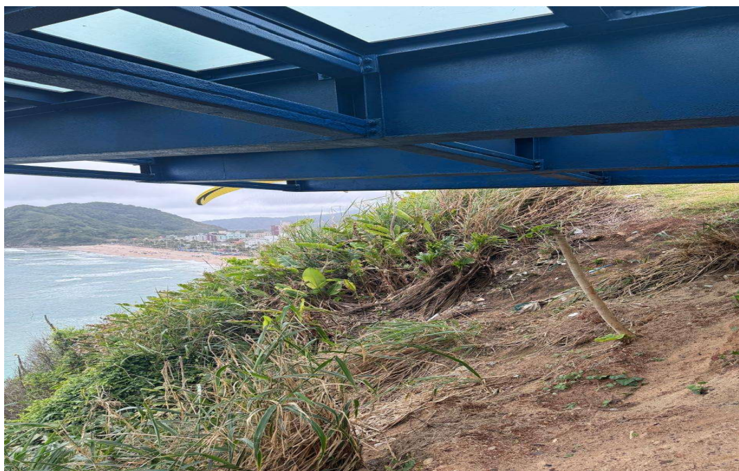
Imagem VI – Recuperação estrutural realizada.
