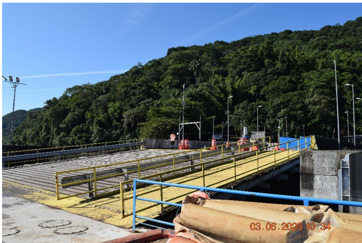
Figura 2: Rampa que conecta o pier flutuante à terra firme na margem Guarujá
