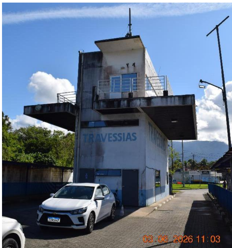
Figura 18: Centro operacional da travessia Bertioga - Guarujá
