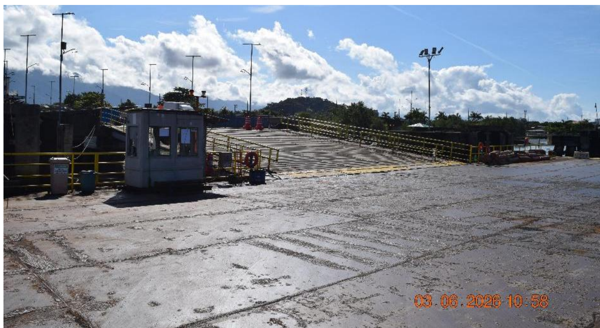
Figura 11: Rampa que conecta o píer flutuante à terra firme na margem Bertioga
